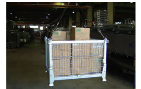
建築資材の積み降ろし
