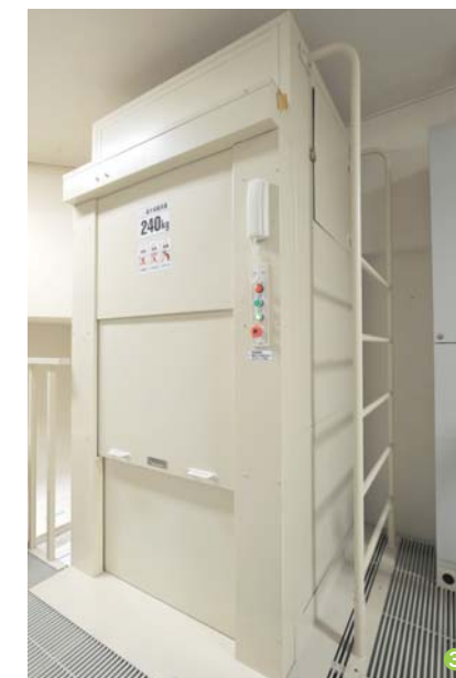
荷物用簡易リフト カルテ庫内の上下移動作業等に利用します。
