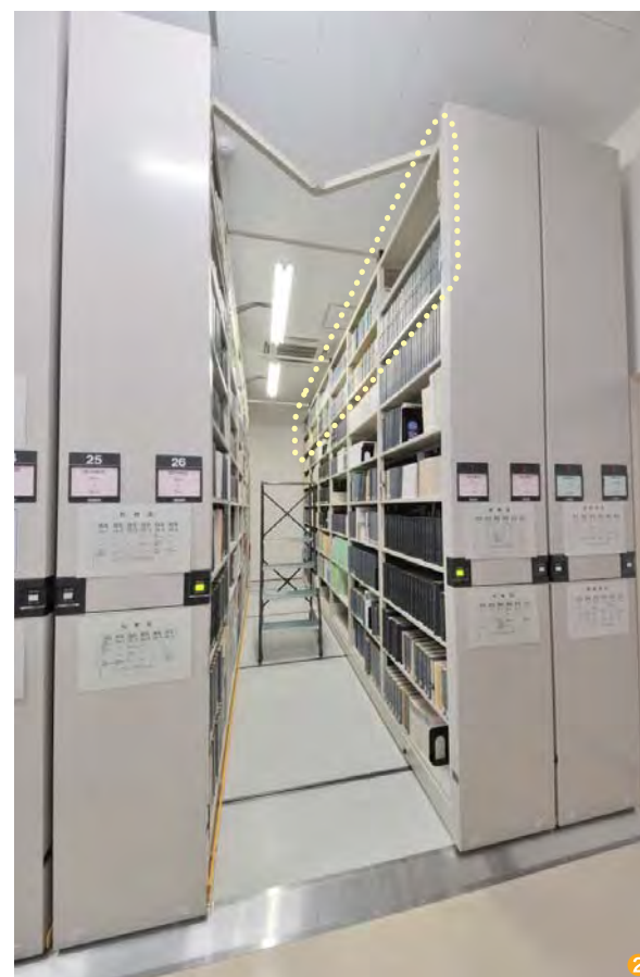
落下防止バー(手動式) 棚の上2段に落下防止バーを取付けました。
